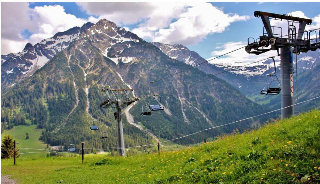
Foto: S. Heilmann Zeitz -Zaferna Lift in Mittelberg
